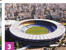
3 Maracanã Stadium, Rio de Janeiro
