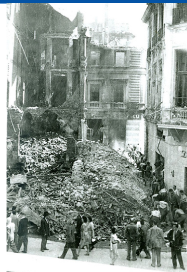
1944, distrugeri provocate de bombardamente în București
