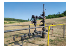
Stație de pompare a gazului metan
