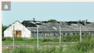
a Clădirea unei cooperative agricole de producție (CAP) abandonată după 1990 (în perioada comunistă, terenurile agricole se aflau în proprietatea fermelor de stat și a cooperativelor agricole)
