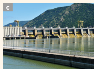
Hidrocentrala Porțile-de-Fier I
