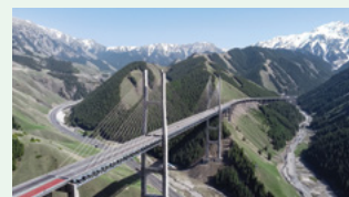
Podul Xinjiang Guozigou, un nod important al celui mai ambițios proiect de infrastructură lansat de China
