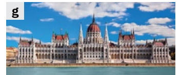
g Clădirea Parlamentului din Budapesta, capitala statului, oraș situat pe ambele maluri ale Dunării.
