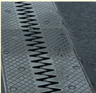
3 Îmbinarea a două părți ale unui pod rutier
