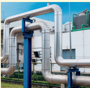
4 Conducte pentru transportul aburului fierbinte
